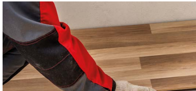
Рис. 13. Монтаж планок ламината
