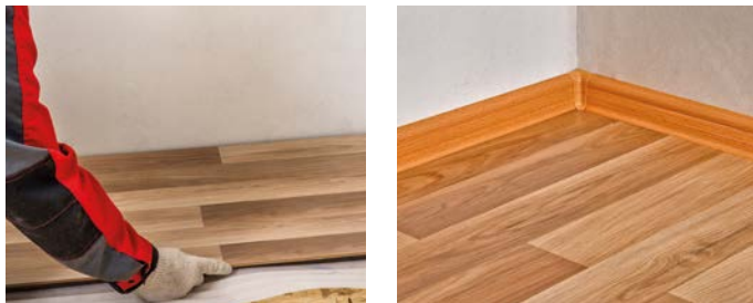
Рис. 5. Монтаж чистового покрытия
