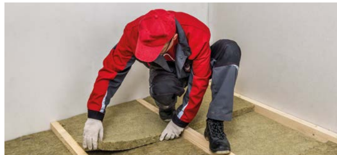
Рис. 2. Монтаж теплоизоляции враспор между лагами
