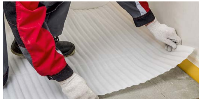
Рис. 12. Укладка подложки под финишное покрытие пола
