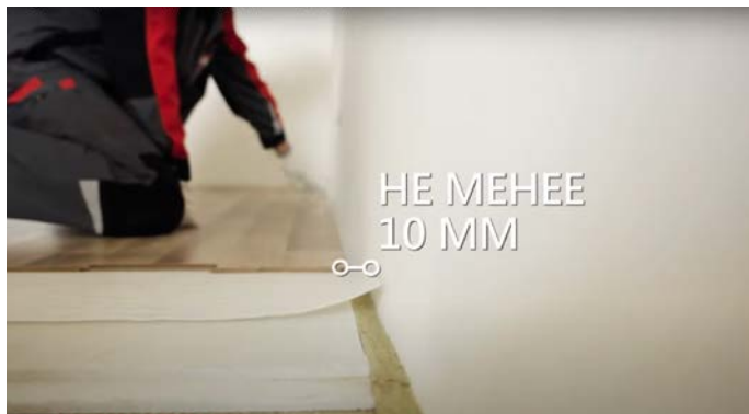
Рис. 15. Укладка ламината с зазором до стены 10 мм (в случае подрезки звукоизоляционных плит по периметру на уровне стяжки)
