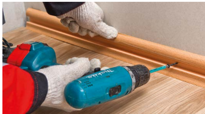
Рис. 16. Крепление плинтуса
