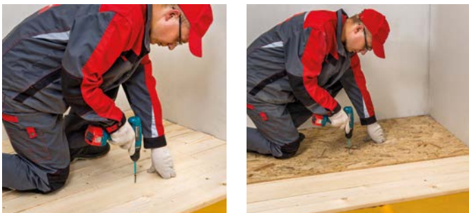
Рис. 4. Монтаж чернового пола
