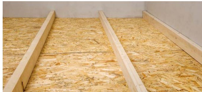
Рис. 1. Подшивка лаг снизу
