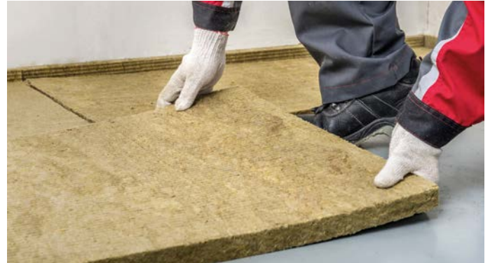
Рис. 7. Укладка плит ТЕХНОФЛОР СТАНДАРТ
