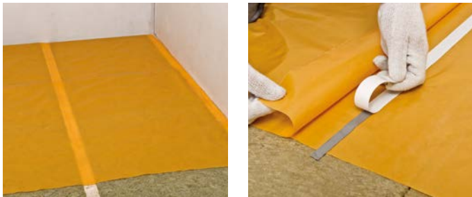
Рис. 3. Монтаж и проклейка нахлестов пароизоляционной пленки
