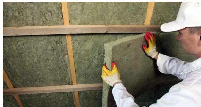
Рис. 4. Укладка второго слоя теплоизоляции
