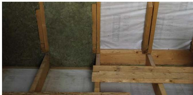
Рис. 2. Подготовленная система для дальнейшего монтажа теплоизоляции
