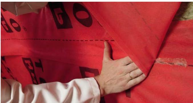
Рис. 6. Проклейка стыков пароизоляционной пленки
