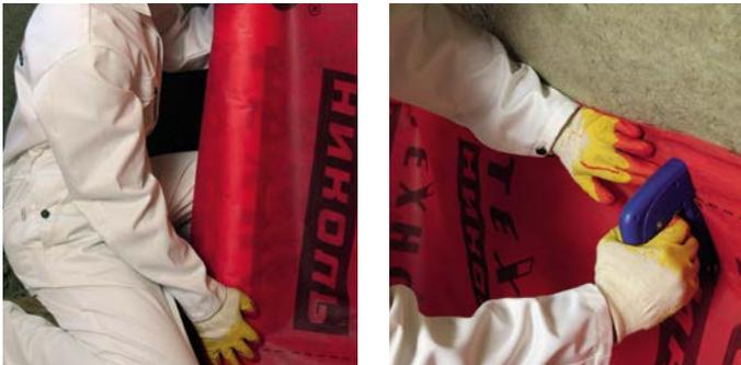
Рис. 5. Укладка и фиксация пароизоляционной пленки
