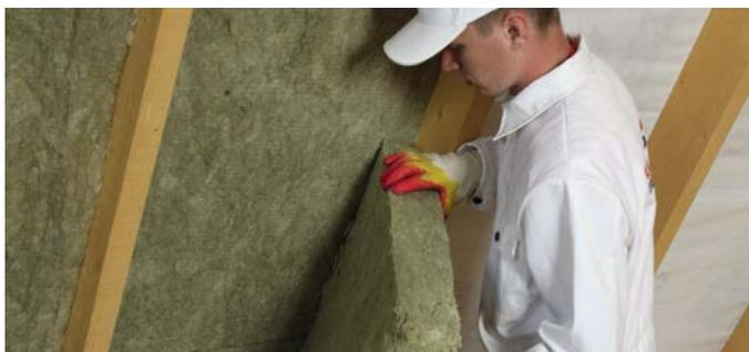
Рис. 3. Монтаж теплоизоляции враспор между стропилами
