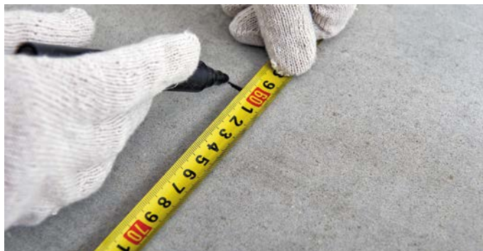
Рис. 2. Разметка основания
