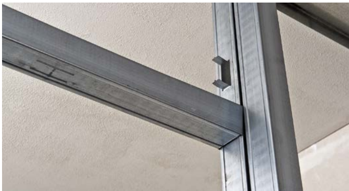
Рис. 4. Установка стоечного профиля (продолжение)
