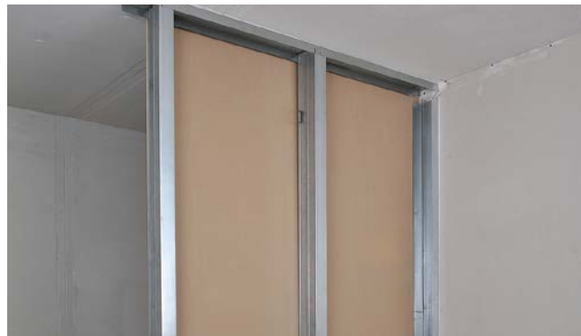
Рис. 5. Обшивка первой стороны перегородки листами ГКЛ
