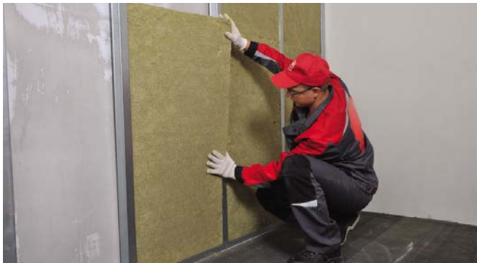
Рис. 12. Монтаж тепло-, звукоизоляционных плит
