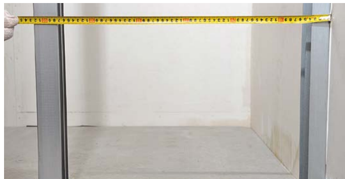
Рис. 4. Установка стоечного профиля
