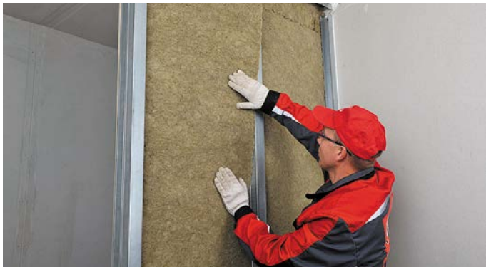
Рис. 6. Монтаж тепло-, звукоизоляционных плит
