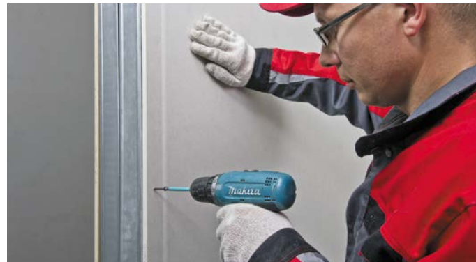
Рис. 13. Обшивка стен листами ГКЛ
