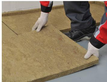
Плиты плотно укладываются между собой с разбежкой швов 600 мм в один слой.
