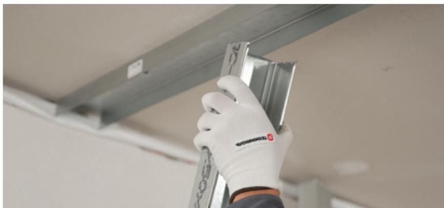
Стойчный профиль устанавливается в строго вертикальном положении. Сначала вставляем его в нижний направляющий профиль, затем в верхний. Фиксируем профиль при помощи саморезов, заклепок или просекателя. Рекомендуемое расстояние между стойками профиля в свету 600 мм. Стойчный вертикальный профиль устанавливается на 10 мм ниже потолка помещения.
