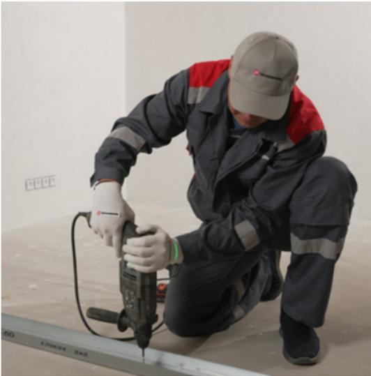
Используем металлический профиль для возведения каркаса. Согласно осям, заранее нарезанный металлический профиль закрепляем при помощи дюбелей к полу.
