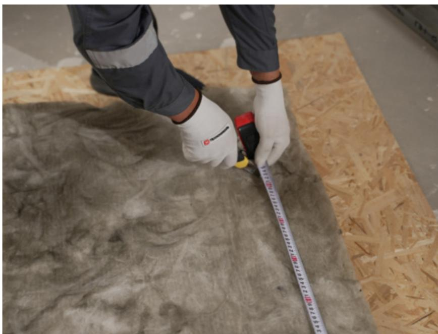
**5.2** Перед укладкой плит звуко- и теплоизоляции необходимо проложить все необходимые коммуникации. Для повышения звукоизолирующей способности перегородки розетки должны быть разнесены. Рекомендуем использовать акустические подрозетники.
