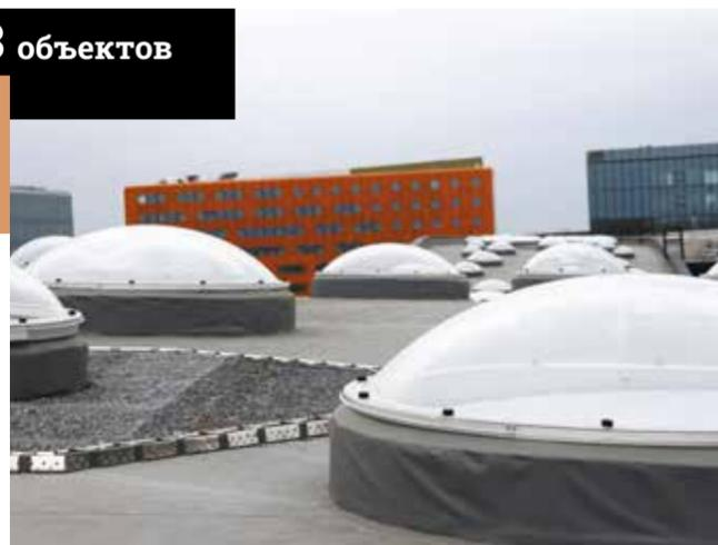
сложную форму, поэтому проектом предусмотрены новаторские технологии выполнения совмещенных кровель, имеющие оригинальные схемы водоотведения осадков. Кроме того, назначение объекта предполагает обширное естественное освещение, для чего предусмотрено 248 встроенных зенитных фонарей, имеющих круглый сферический купол.
