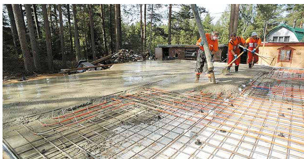
Подача бетонной смеси в опалубку при помощи бетононасоса.
