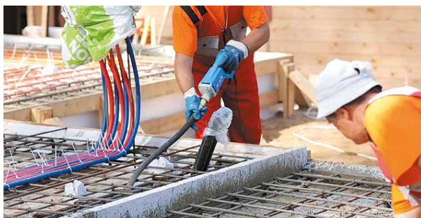
Вибрация бетонной смеси в ребрах жесткости.
