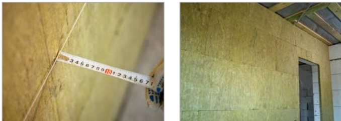
Рис. 10. Монтаж звукоизоляции
