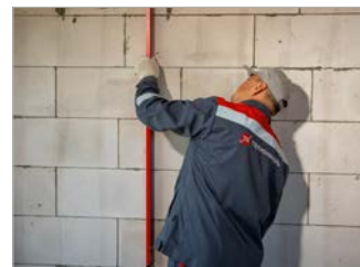
Рис. 3. Определение кривизны стены
