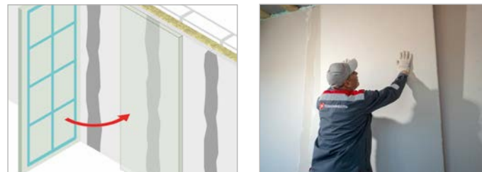
Рис. 15. Крепление листов ГКЛ/ГВЛ второго слоя
