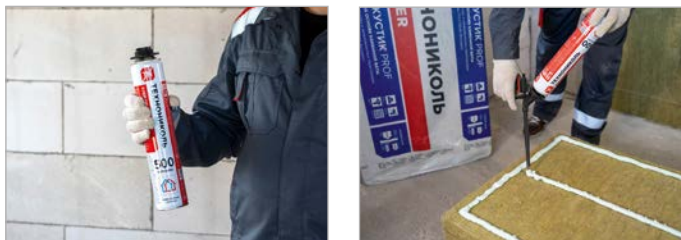
Рис. 6. Подготовка баллона и нанесение клея-пены
