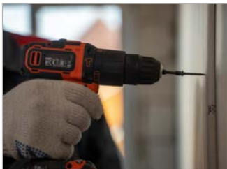
Рис. 16. Крепление листов ГКЛ/ГВЛ второго слоя
