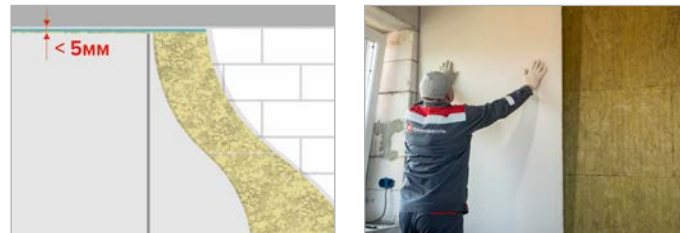
Рис. 13. Монтажный зазор
