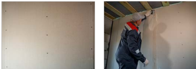
Рис. 17. Заделка швов
