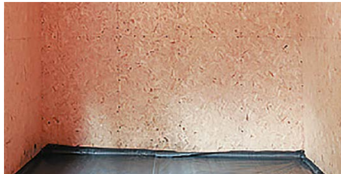
Рис. 23. Обшивка внутренней поверхности стен
