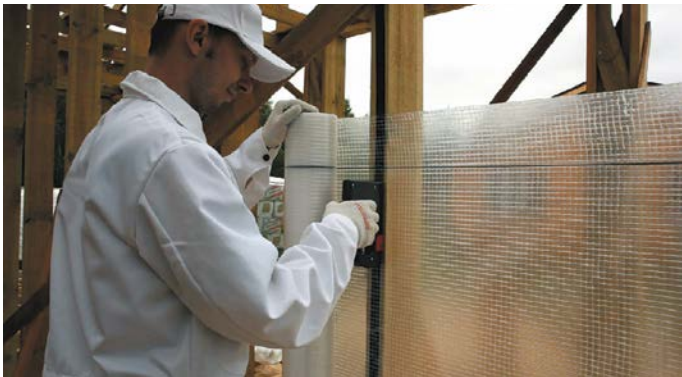
Рис. 19. Монтаж пароизоляционной пленки
