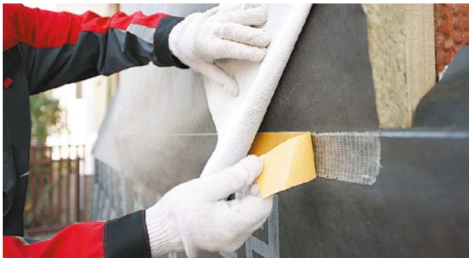
Рис. 5 б. Проклейка стыков полотен ветро-, влагозащитной мембраны
