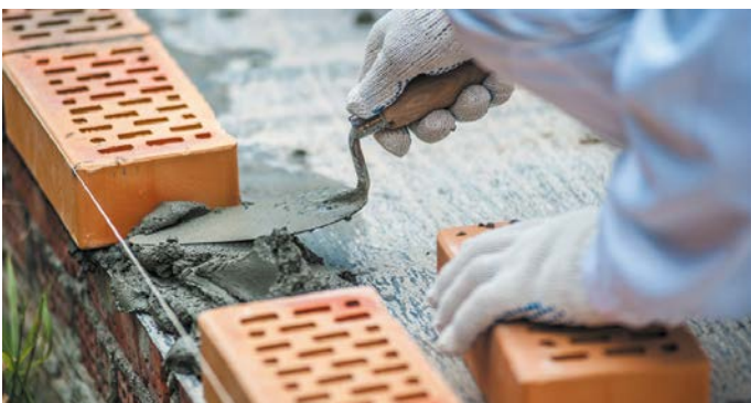
Рис. 9. Монтаж внешней версты
