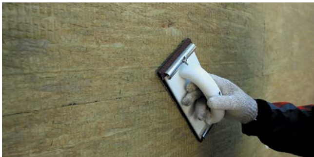
Рис. 32. Шлифовка стыков плит теплоизоляции наждачной бумагой
