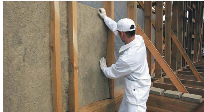
Рис. 20. Монтаж теплоизоляционных плит
