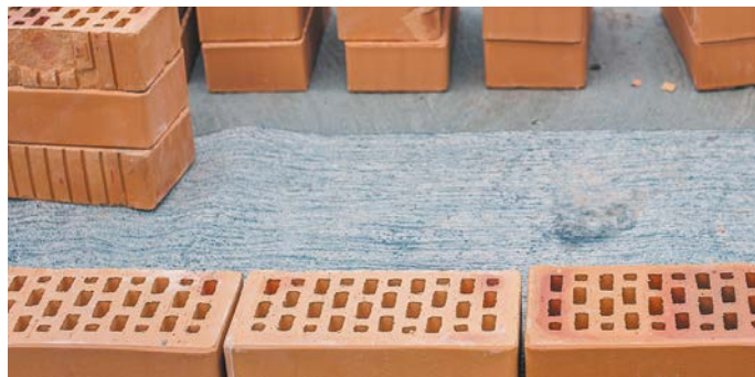
Рис. 7. Гидроизоляционная отсечка
