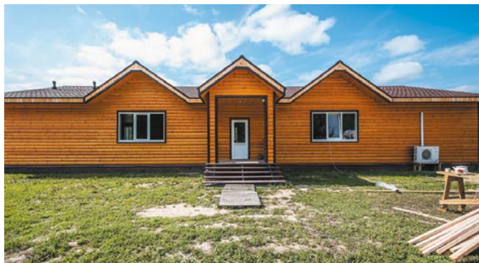
Рис. 22. Монтаж облицовочного материала
