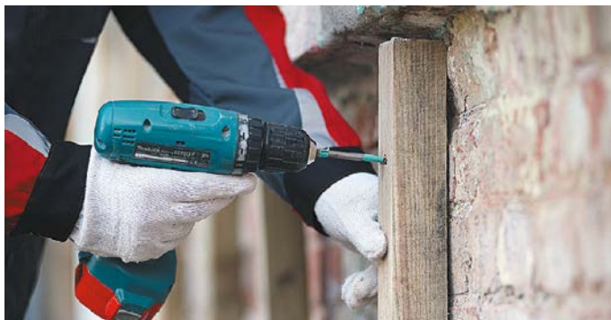
Рис. 1. Крепление вертикальных стоек деревянного каркаса
