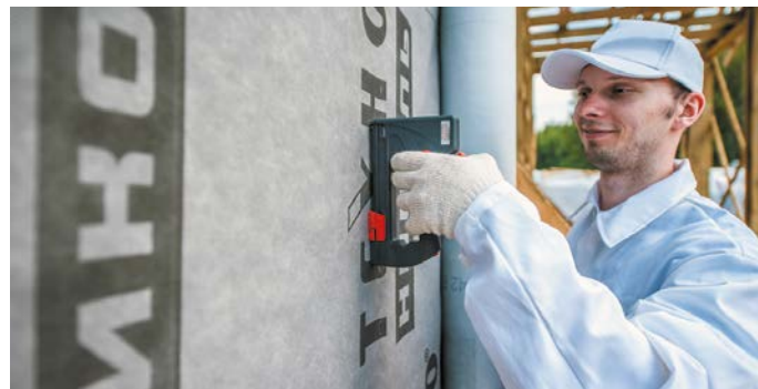
Рис. 21. Монтаж ветро-, влагозащитной мембраны
