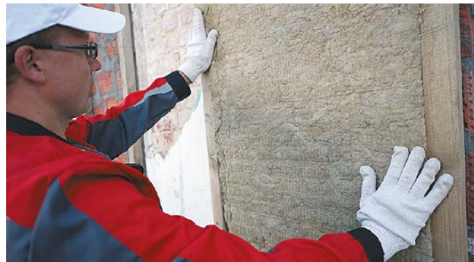
Рис. 2. Монтаж теплоизоляционных плит в вертикальный каркас
