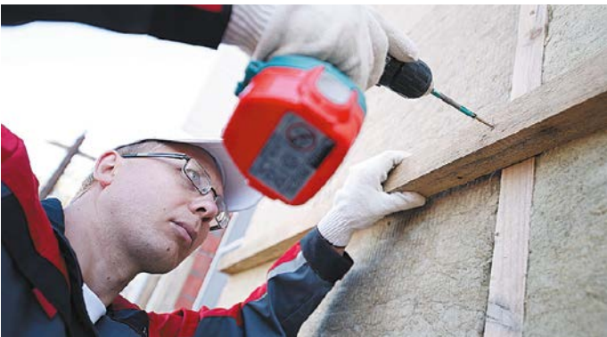
Рис. 3. Установка горизонтального каркаса
