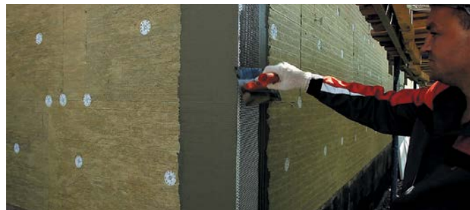
Рис. 35. Установка усиливающих профилей на углах здания
