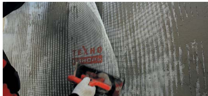
Рис. 37. Армирование базового штукатурного слоя стеклосеткой
