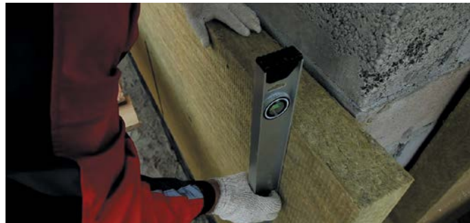
Рис. 29. Приклейка плиты тепло-, звукоизоляции к стене
