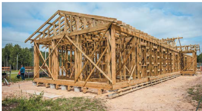
Рис. 18. Установка деревянного каркаса
