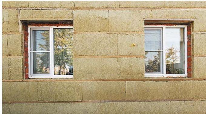
Рис. 4. Монтаж теплоизоляционных плит в горизонтальный каркас
