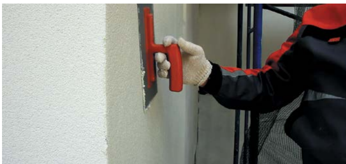
Рис. 39. Нанесение декоративного слоя штукатурки
