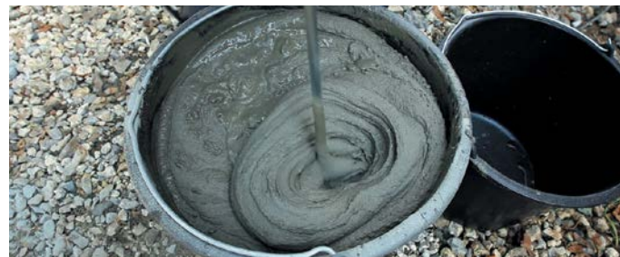
Рис. 25. Замешивание клея для приклейки теплоизоляции
