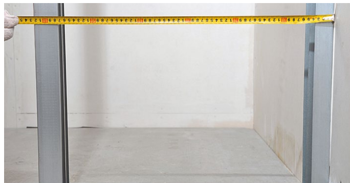
Рис. 4. Установка стоечного профиля
