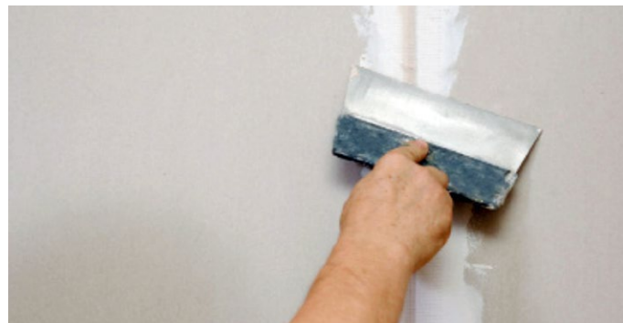
Рис. 8. Заделка швов
