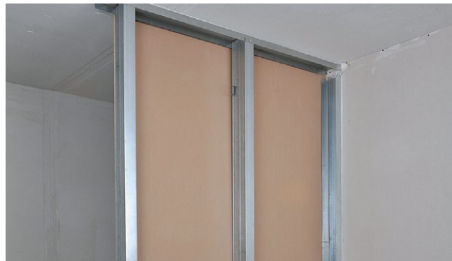
Рис. 5. Обшивка первой стороны перегородки листами ГКЛ
