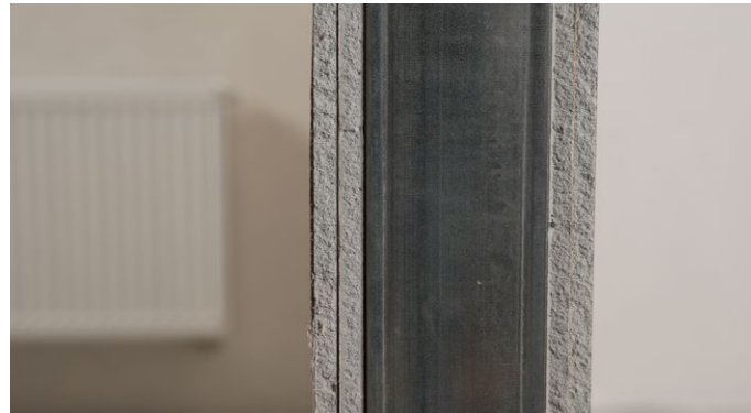
Рис. 7. Обшивка второй стороны перегородки листами ГКЛ
