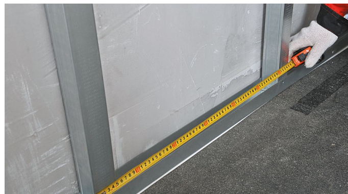
Рис. 11. Установка направляющего и стойечного профилей
