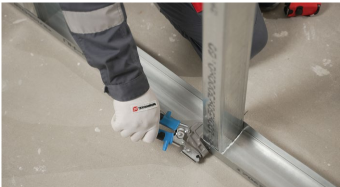
Рис. 4. Фиксация стоечного профиля
