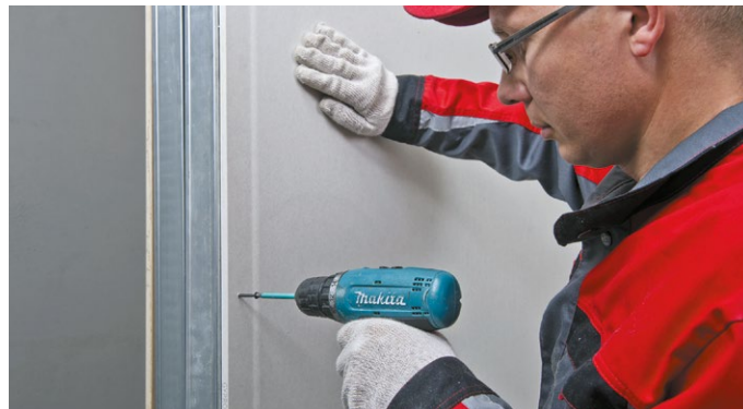
Рис. 13. Обшивка стен листами ГКЛ
