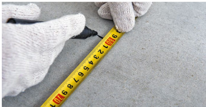
Рис. 2. Разметка основания
