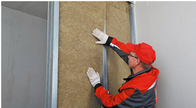
Рис. 6. Монтаж тепло-, звукоизоляционных плит
