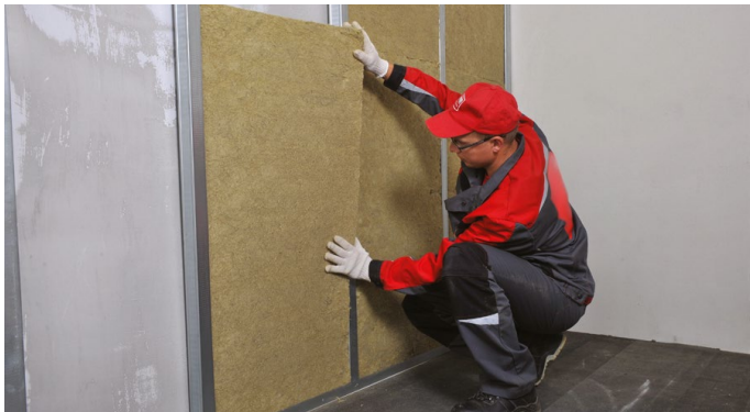
Рис. 12. Монтаж тепло-, звукоизоляционных плит
