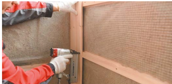
Рис. 7. Устройство внутренней обшивки
