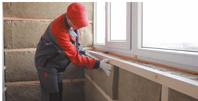
Рис. 4. Укладка плит теплоизоляции второго слоя
