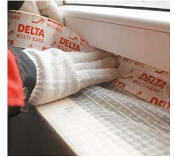
Рис. 12. Проклейка примыканий пароизоляции к стенам и окну
