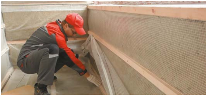
Рис. 10. Монтаж пароизоляционной пленки
