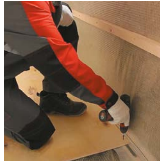
Рис. 13 . Установка покрытия пола
