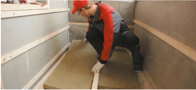
Рис. 9 Укладка теплоизоляционных плит
