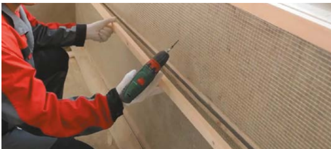
Рис. 6. Монтаж контррейки
