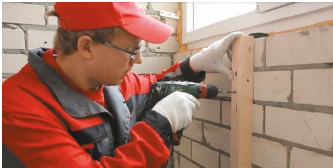
Рис. 1. Установка вертикального каркаса под теплоизоляцию
