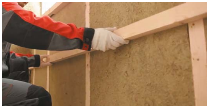
Рис. 3. Установка горизонтального каркаса под теплоизоляцию
