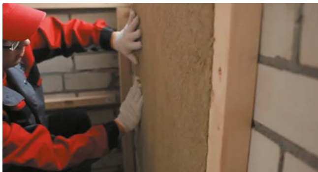
Рис. 2. Укладка плит теплоизоляции первого слоя
