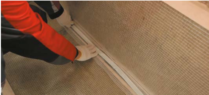
Рис.11. Проклейка нахлестов пароизоляции
