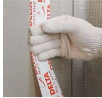
Рис. 12. Проклейка примыканий пароизоляции к стенам и окну
