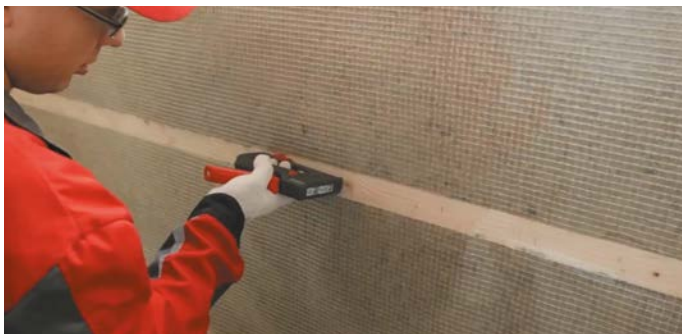
Рис.5. Монтаж пароизоляции
