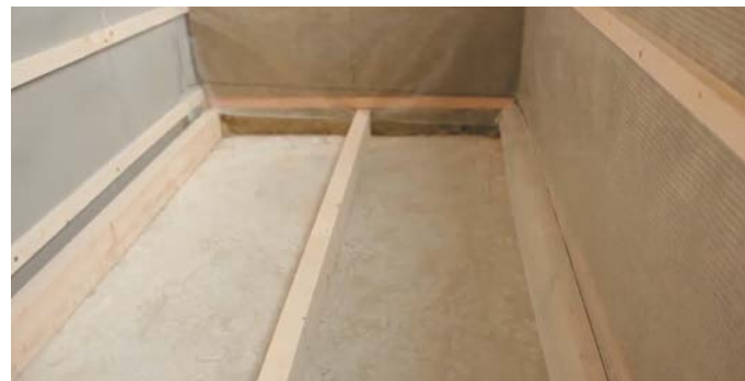
Рис. 8. Монтаж деревянных лаг на пол
