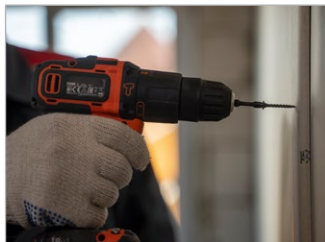
Рис. 16. Крепление листов ГКЛ/ГВЛ второго слоя
