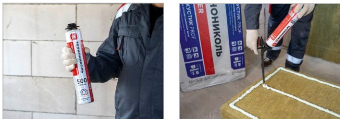
Рис. 6. Подготовка баллона и нанесение клея-пены
