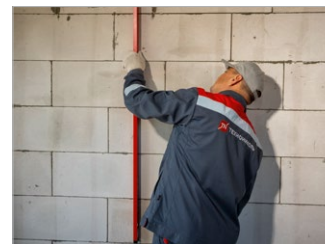
Рис. 3. Определение кривизны стены
