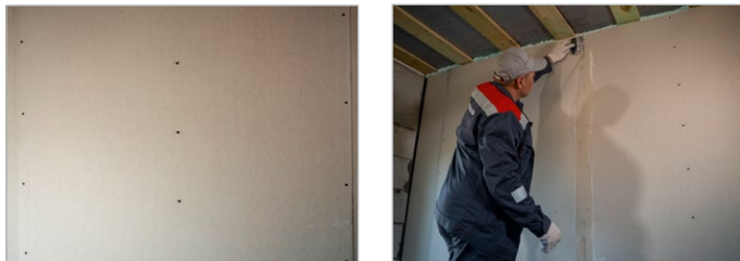
Рис. 17. Заделка швов
