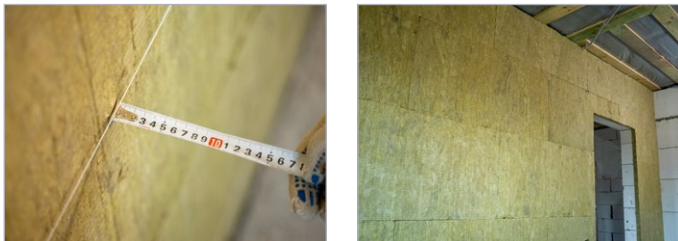
Рис. 10. Монтаж звукоизоляции
