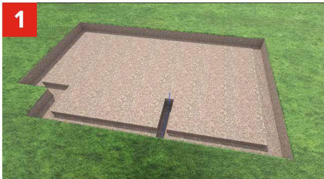
**1** Перед началом работ необходимо произвести расчистку котлована. При механической разработке котлована снимается только верхний плодородный слой (30-40 см). По возможности разработку котлована провести до материнского грунта.
