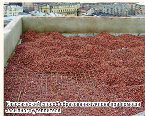
Классический способ образования уклона при помощи засыпного утеплителя
