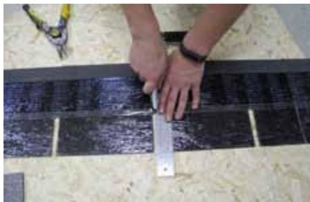
Рис. 7. Деление плитки на лепестки
