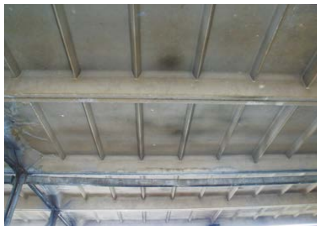
Реконструкция крыш с основаниями из ребристой плиты — наиболее сложная задача.
