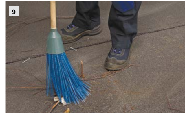
9 Тщательно подготовьте несущую поверхность: удалите слабые фрагменты, очистите от загрязнений и мусора.
