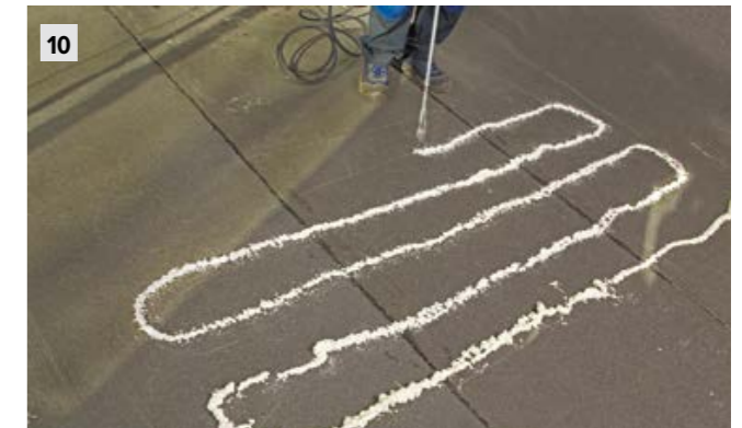
10 Наносите клей-пену полосами, оптимальное расстояние между полосами — 300 мм. Примерно через 10 минут после нанесения, когда закончится процесс поднятия и стабилизации пены, можно начинать укладку плит LOGICPIR PROF CXM/CXM.
